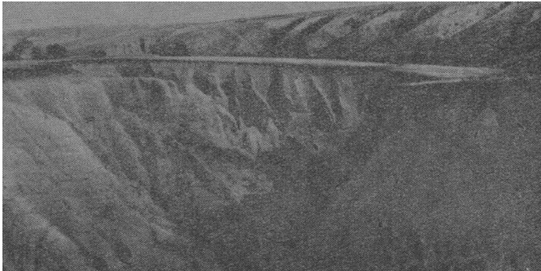
Рис. 152. Глубокий донный размыв в песчаном грунте в коротком отвершке лощины (станция Клетская Сталинградской области)
