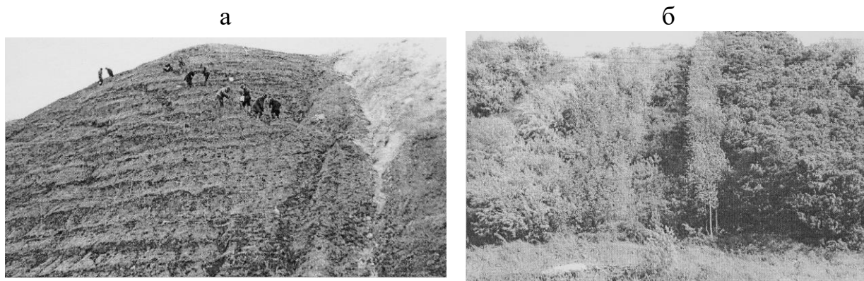
Рис. 13.1. Облесение откоса суглинистого конвейерного отвала: а – ручная посадка лесных культур, б – общий вид участка через 15 лет
